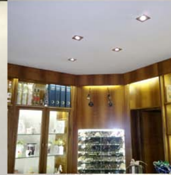
Pasticceria Pont Canavese (TO) Installazione 2010 Illuminazione soffitto, parete e vetrine. Spot 50 e Stripdsp
