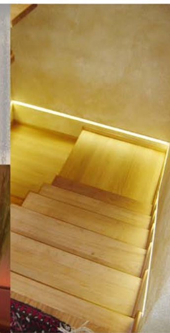
Appartamento privato Frasinetto (TO) Installazione 2011 Illuminazione vano scala Stripdsp + Profiall
